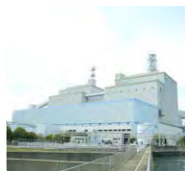
J-POWER 松浦火力発電所 2号機:100万kW (石炭火力)
