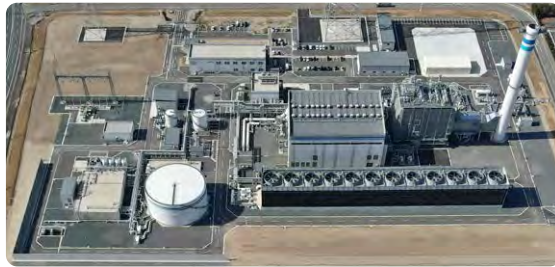
ひびきLNG火力発電所
