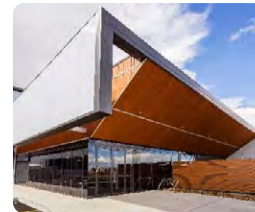
豪州案件の 組み入れ物件例(物流施設)
