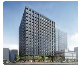
電気ビル西館
