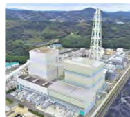
九州電力 松浦発電所 2号機:100万kW (石炭火力)
